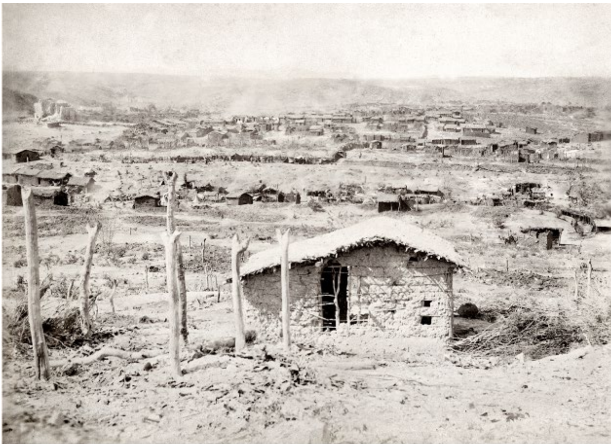
Imagen 1: Vista parcial de Canudos, 1897
